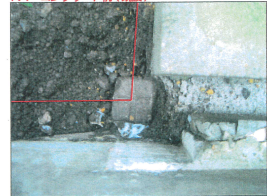
K4 コンクリート杭(既設)
